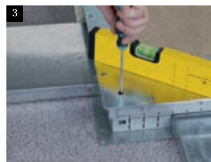
3 Nivelar con los tornillos
