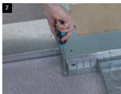
2 Introducir las canales y atornillar al suelo
